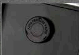
Automatisch drukvereffeningsventiel
